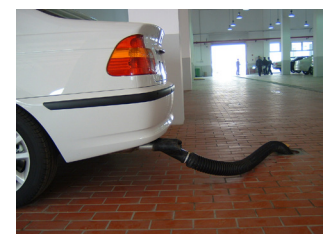
Système d'extraction de gaz d'échappement par le sol
